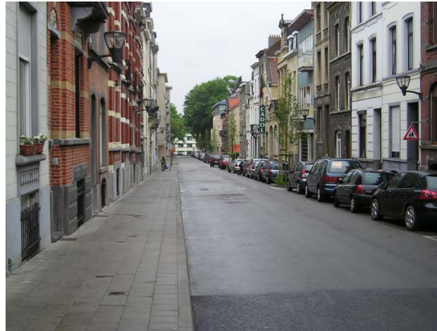
Les dalles de béton 30 x 30 cm sont les plus communément utilisées comme revêtement de trottoirs (ici rue Delcoigne).
