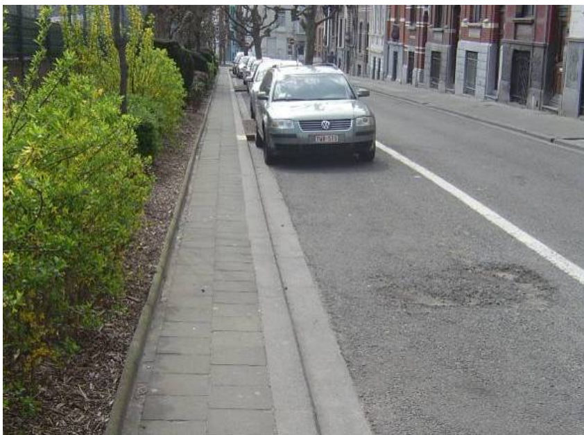
Il subsiste à Koekelberg quelques trottoirs qui ont une largeur inférieure à la norme RRU : 1,5 m (ici la rue de l'Armistice).
