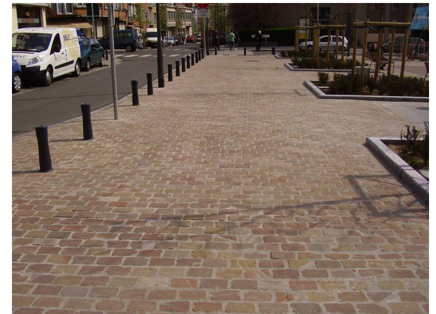
Les trottoirs bordant la place Vanhuffel sont formés de pavés en grès, matériau résistant.
