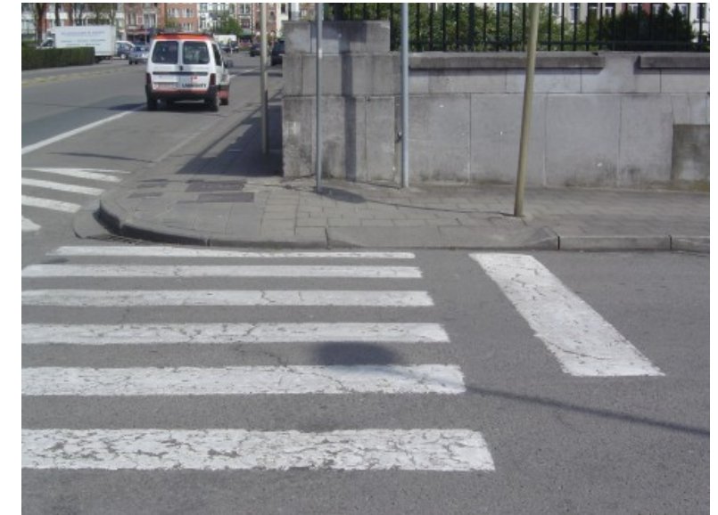
Rue des Braves : l'abaissement du trottoir est brutal (plan incliné) et ne coïncide pas avec le tracé du passage piétons peint.
