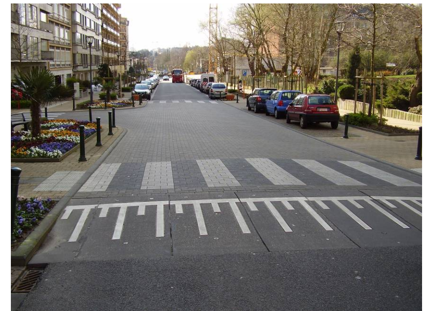
Le plateau sur l'avenue de la Basilique est composé de klinkers, ce qui favorise la mise en évidence de celui-ci et contribue à ralentir la vitesse des automobilistes.
